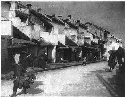
La rue des Chargeurs en 1896 dans le quartier des trente-six rues. Coll. Loignon
